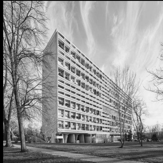
Le Corbusier | Unite d'Habitation | Marsella, Francia | 1945-1952
